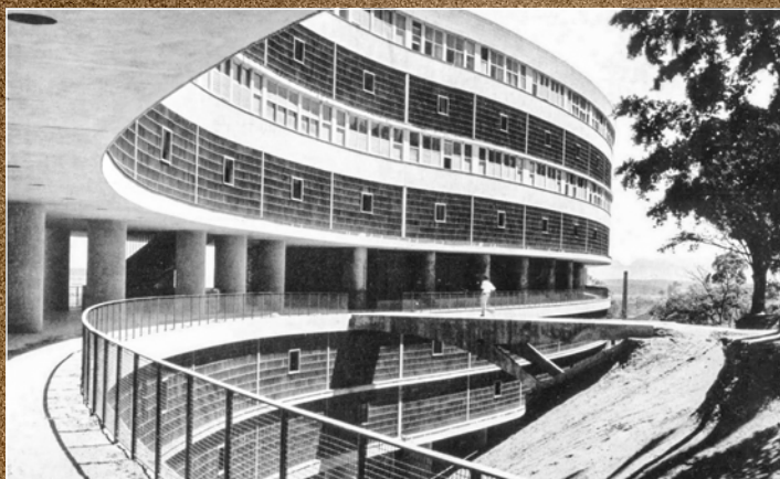
Conjunto Residencial Prefeito Mendes de Moraes (“Pedregulho”), projetado por Affonso Eduardo Reidy
